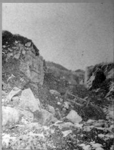
Ruines du fort de Siouville.
