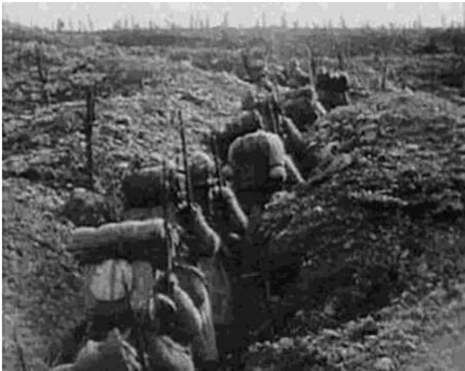
Relève de section dans une tranchée (DR)
