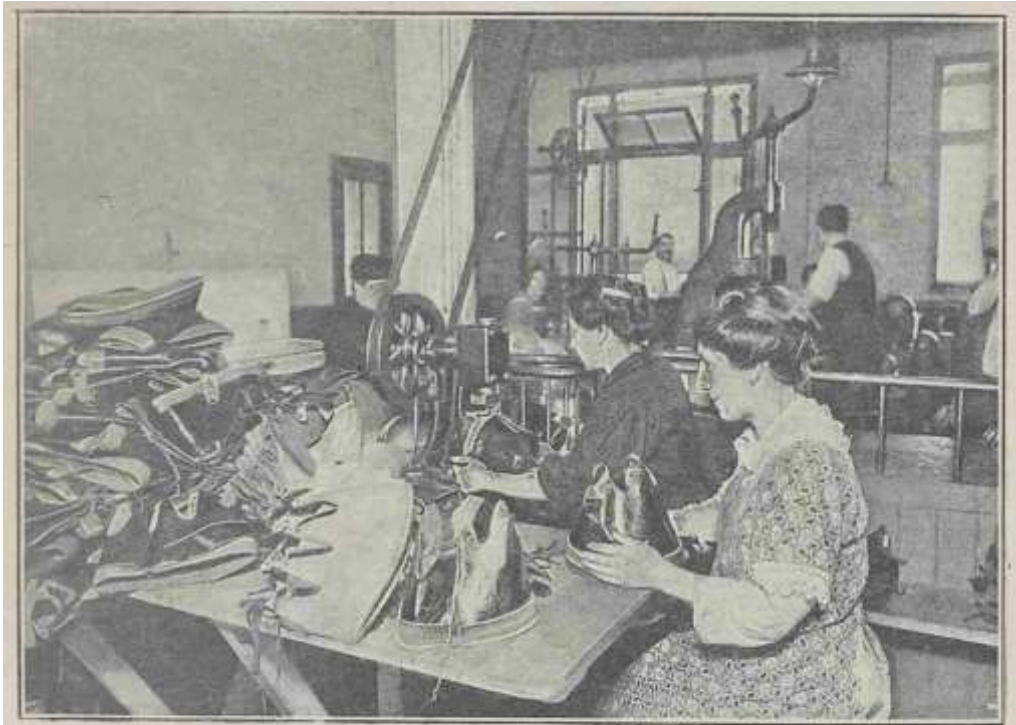
LE PERÇAGE DES TROUS DANS LE TURBAN DE LA COIFFE Des crampons spéciaux, soudés à l'intérieur de la bombe, pénètrent dans ces trous et sont ensuite rabattus sous le cuir de la coiffe, qu'ils maintiennent en place.
