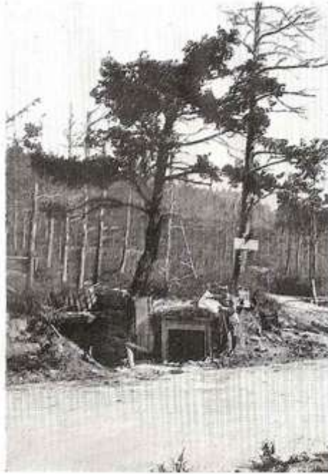
ABRI AU COL DE WESTHEIN. (Cliché LL.)
